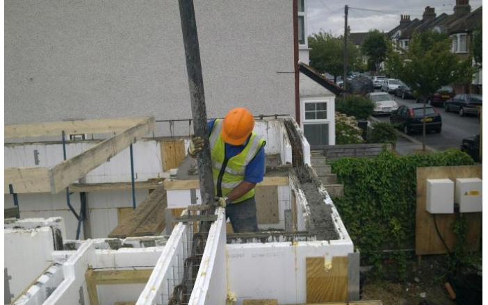
A typical concrete pour on site using a boom pump
